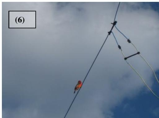
Je me résous à transformer la beam en un grand dipôle vertical en mettant les 2 éléments en parallèle au lieu d'antiparallèle (pour l'effet beam).
