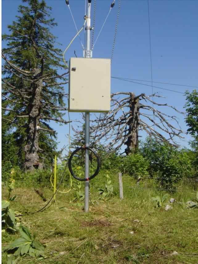
Ci-contre, le câble d'antenne est bobiné sur lui-même (environ 8 spires de diamètre 50cm) pour créer une self d'arrêt.
