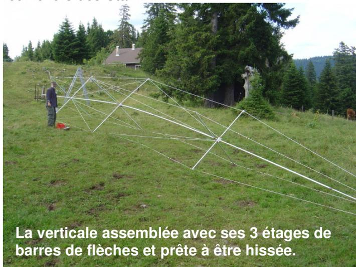
**La verticale assemblée avec ses 3 étages de barres de flèches et prête à être hissée.**
