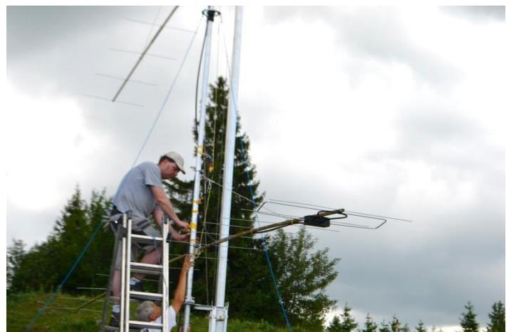
Puis, l'antenne du bas est trop basse est va buter contre le mât lorsqu'on tourne le rotateur.
