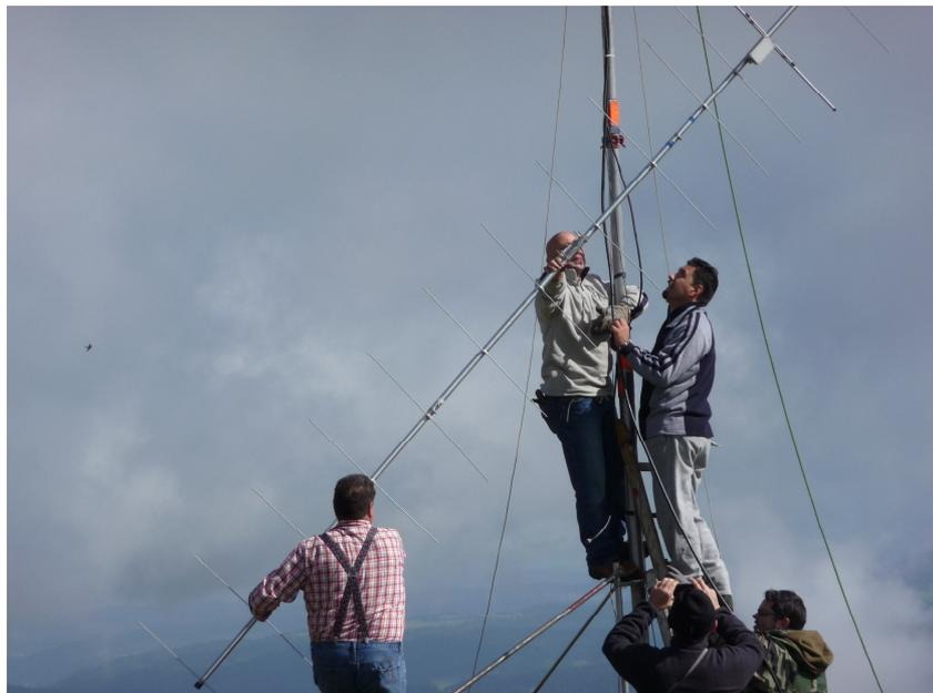
On peut enfin dresser les mâts des groupes SW et SE avec les antennes dessus, descendre le groupe NW des 4x9 pour mettre les antennes parallèles.
