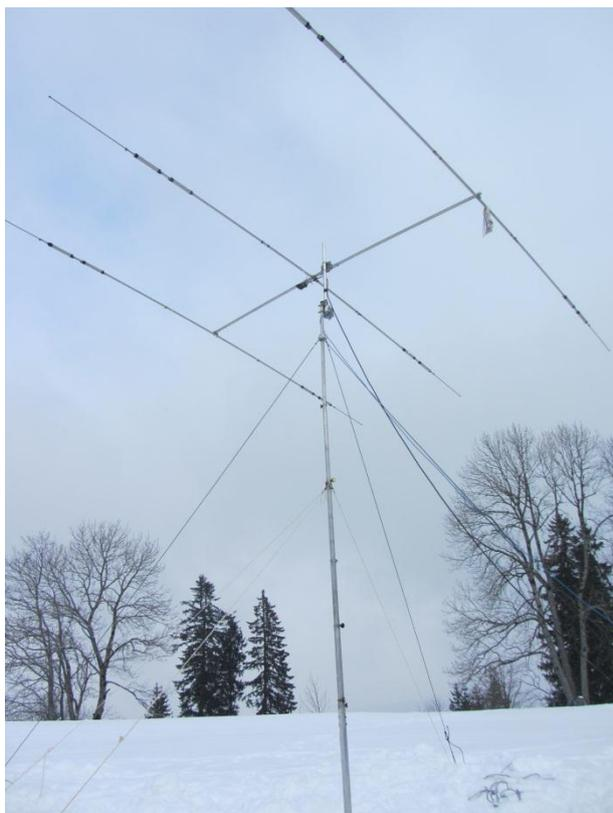
L'installation se poursuit le vendredi. Là un 2<sup>ème</sup> blème : Pas moyen, à 3 seulement de déployer le mât télescopique, avec le poids de l'antenne et du rotateur dessus. Cela demande trop d'effort pour un seul OM, car il faut que les autres tiennent les haubans pendant le hissage. Impossible de monter l'antenne plus haut que 2m50.
