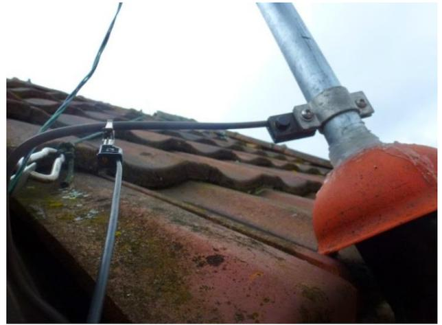
Résultat : Je peux accorder le fil du paratonnerre sur 3,5MHz, 10MHz, 14MHz et 18MHz. Et même encore dans le haut de la bande des 160 mètres. Mon analyseur d'impédance d'antenne me dit que je pourrais même accorder sur toutes les bandes si je n'étais pas trop flemmard pour aller chercher le Tuner à la cave.
