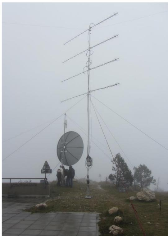
On reprend vers 14H00 ; montage des 4x20EL sur le mât, installation des coaxiaux puis on hisse et une fois que tout est en haut, on met en place la boîte PA-LNA au mât. Quelques pauses au milieu du travail pour aller se réchauffer dans le local ; on balaye les nombreuses mouches crevées qui jonchent le sol, un coup d'aspirateur, puis la mise en place des tables et de la STN 432 à HB9BLF.
