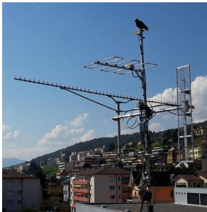
A droite ci-dessus, l'implantation des antennes sur mon toit. Avec un couple de 2x3 éléments Moxon pour 144MHz et la Yagi 55éléments 23cm sur le même support.
