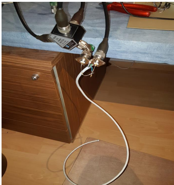
Le stub en cours de réglage à l'analyseur de réseau
