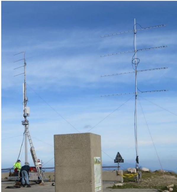
Au sommet l'antenne panneau pour 23cm, puis entre les 2 Yagi 70 cm, un groupement en H avec 4x23EL. Également pour 23 cm.
